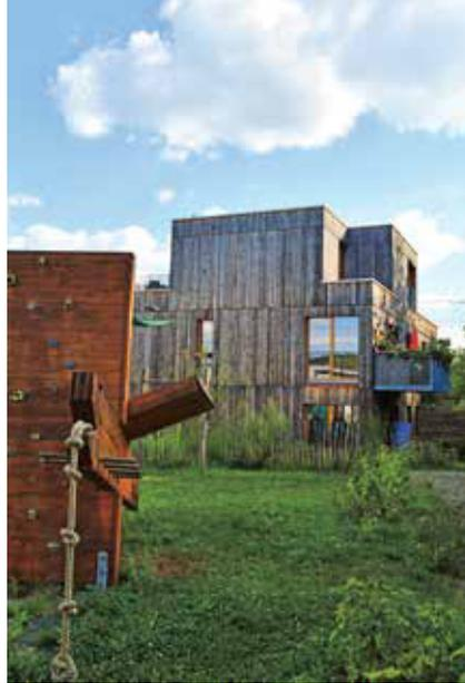
Nach Abwägung unterschiedlicher Materialien wie Lehm oder Stroh entschied sich die Baugruppe für die Umsetzung des Projekts in Holzleichtbauweise mit Zellulosedämmung.
